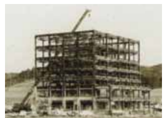
建設中の飯能キャンパス
