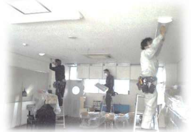
蛍光灯をLEDに付け替え、保育室が明るくなりました。
