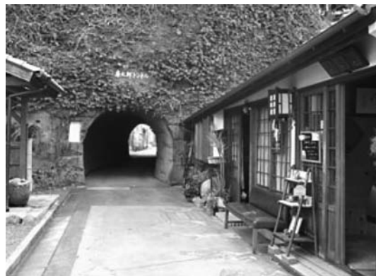
写真6 廉太郎トンネル
